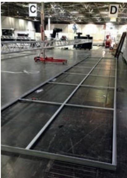
Die Abhängung wurde im Sandwichverfahren aufgebaut. Zum Messegang der Druck, in der Mitte eine Sperrschicht aus Blockoutmaterial, um ein Durchscheinen der eingebauten Versteifungen zu verhindern und auf der Innenseite ein unbedruckter, weißer Stoff. Die Bespannung wurde stehend am Boden vorgenommen.
