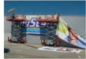
An der Fassade eines großen Möbelhauses wurden Aluminium-Rahmen montiert und exakt ausgerichtet. Im Anschluss konnten die Monteure mit zwei Scherengitter-Hebebühnen die großformatigen Banner befestigen.
