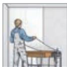
**2a.** Zur Verklebung wird Vlieskleber im Ansatz 1:10 verwendet.
