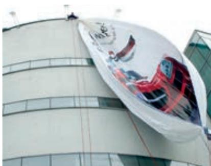
Zur Befestigung des Riesenposters werden Monteure mit Klettererfahrung benötigt. Das Poster wird am Dachrand befestigt und nach unten geworfen.
