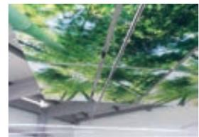
Trotz leichter Abstände zwischen den Rahmen wirkt das Bild wie aus einem Stück. Zwischen den Rahmen lassen sich weitere Abhänger platzieren.
