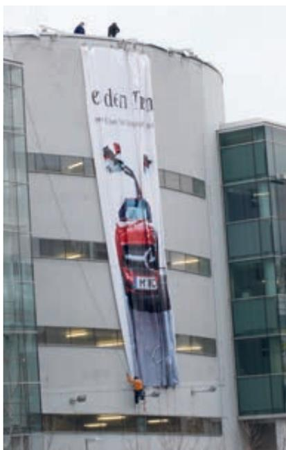
Ein Kletterer seilt sich danach vom Dach ab und befestigt die große Werbefläche an der Hausfassade. Erst wenn die Fassadenwerbung faltenfrei und straff verspannt befestigt wurde ist der Auftrag gelungen.
