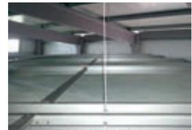
Mittels geeigneter Abhängung an Stahlseilkonstruktionen werden die Rahmen auf die richtige Höhe gebracht.
