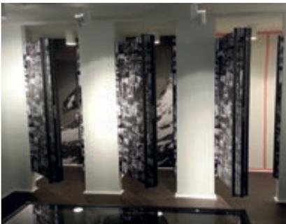
Zur Verkleidung der Türen für die Umkleidekabinen wurden Motive auf Folie für mittelfristige Einsatzzwecke gedruckt und auf Melaminharzplatten geklebt.
