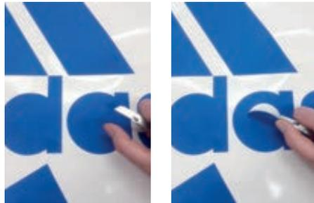
In Handarbeit werden die Plotts entgittert und danach appliziert. Damit ist der Übertrag auf das geplante Objekt fachgerecht vorbereitet.
