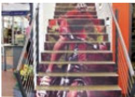
Dieses Bildmotiv wurde auf Hartschaumplatten gedruckt. Durch die Anbringung der Platten an der Setzstufe erhielt die Treppe einen spektakulären neuen Auftritt (zu sehen bei Fahrrad Willner, Ingolstadt)
